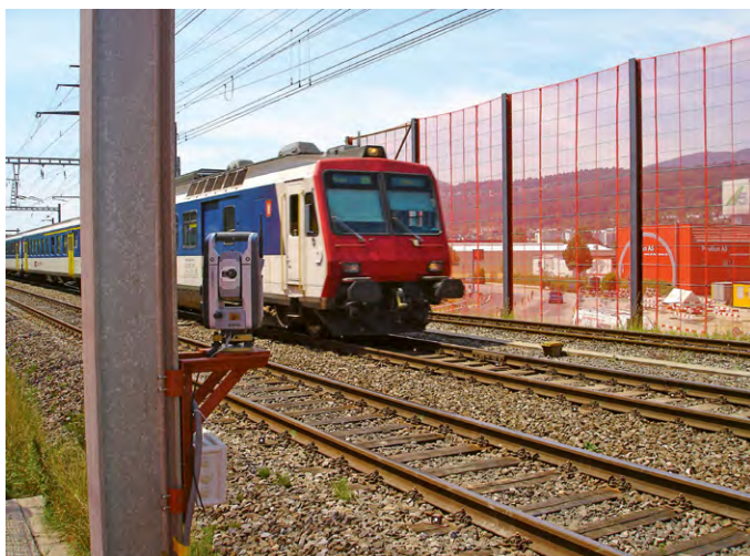
Gleisüberwachung nach SBB-Vorgaben – zuverlässig unterstützt die Trimble Monitoring Lösung einen sicheren Schienenverkehr.
