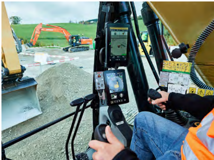
Abb. 10: Anwendungsbereich von swipos®: GNSS-gestützte Echtzeit-Positionierung einer Baumaschine, inkl. automatischer Steuerung der Grabtiefe. Monitor im Cockpit (Trimble Earthworks; Foto Sitech Schweiz AG).
