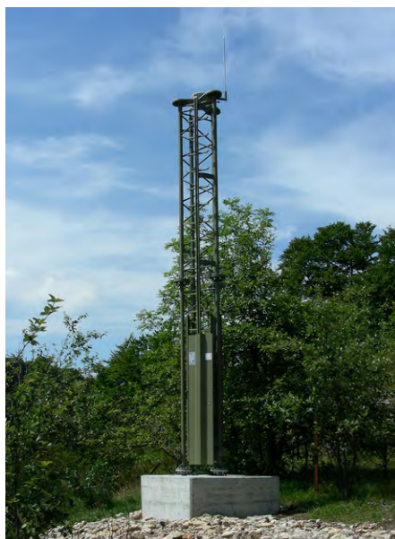
Fig.4: Mât d'antenne de la station GNSS permanente «Bourrignon» du réseau GNSS automatique AGNES (photo swisstopo).
