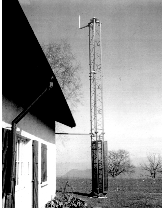
Abbildung 4.3-5: GPS-Mast in Zimmerwald mit Bolzen Z_0 im Fundamentsockel
