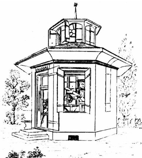
Abbildung 4.3-1: Alte Sternwarte Bern (1821-1876): Fundamentalpunkt des bisherigen Bezugssystems CH1903
